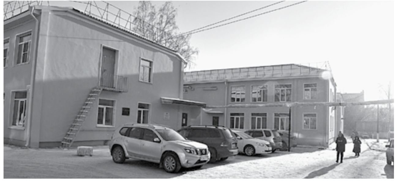
Фасад уже обновлен.
