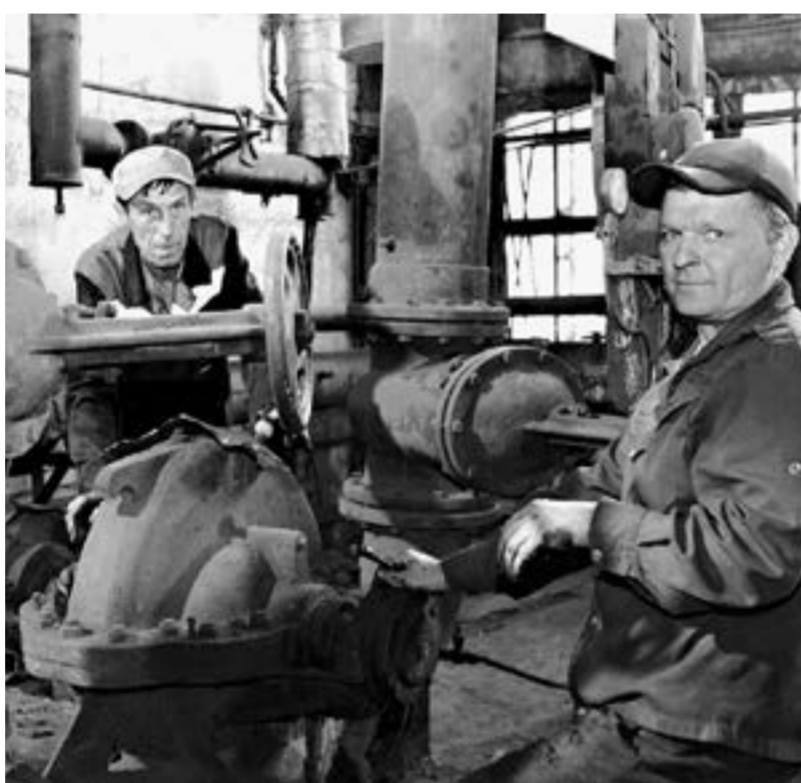
Слесари нательной № 29 в Камне-на-Оби готовят к работе сетевой насос.
