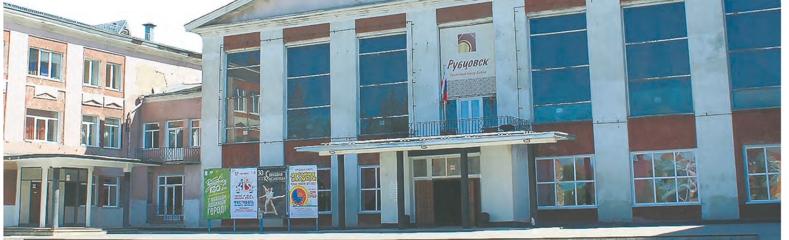
ДК «Тракторостроитель» нуждается в капитальном ремонте.
