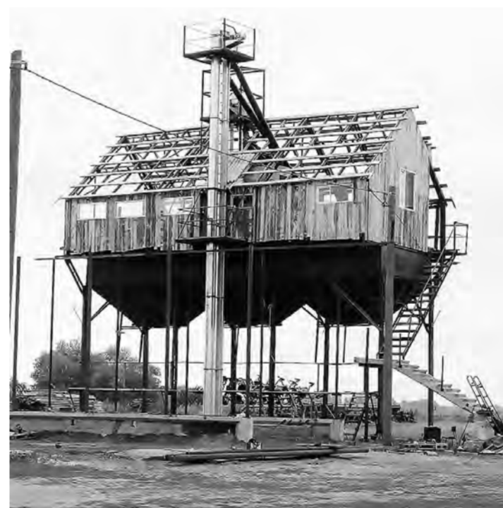
В хозяйстве завершается строительство нового мехтока.
