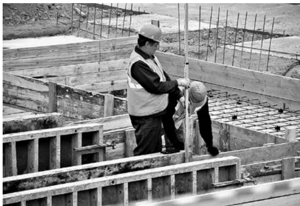
Перед заливкой фундамента.
