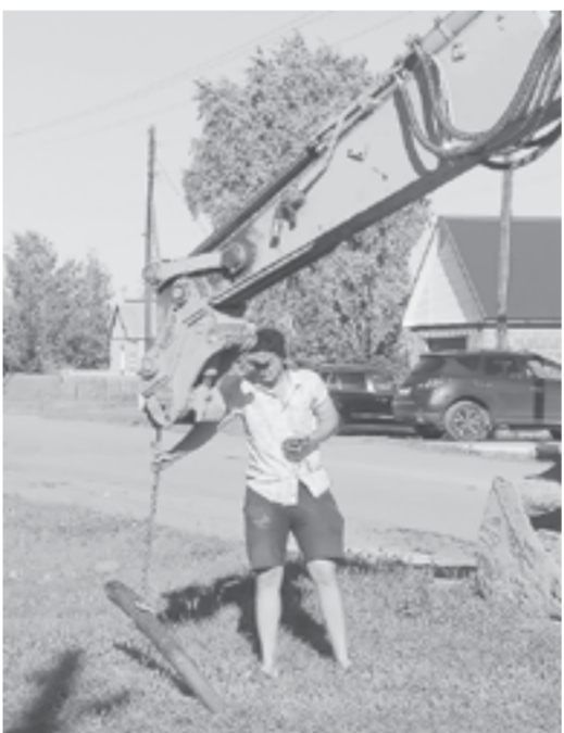
Замена водопроводных сетей в Родино.
