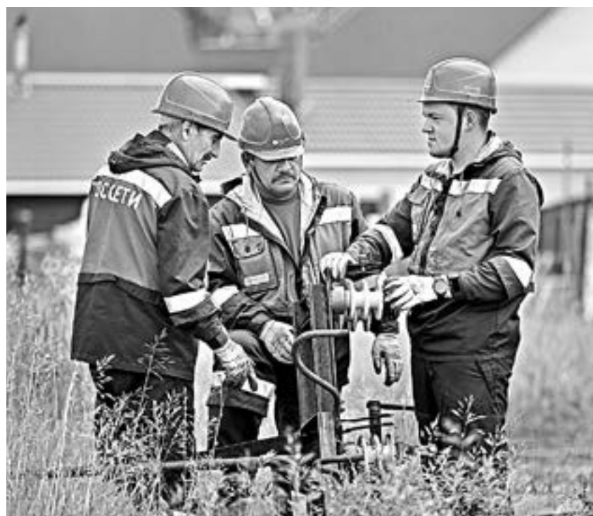
Реконструкция завершена на 60%.
