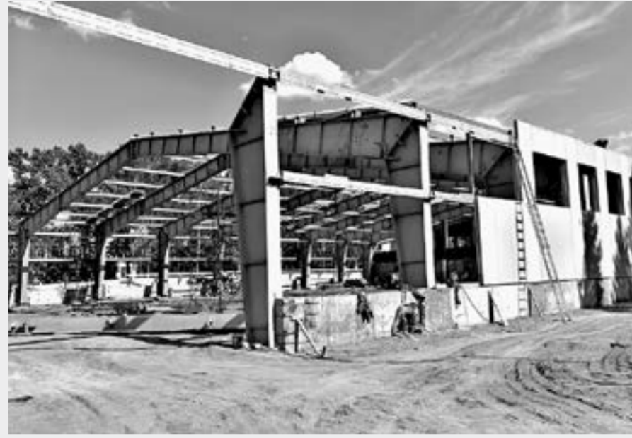
Будущий спорткомплекс строится хорошими темпами.
