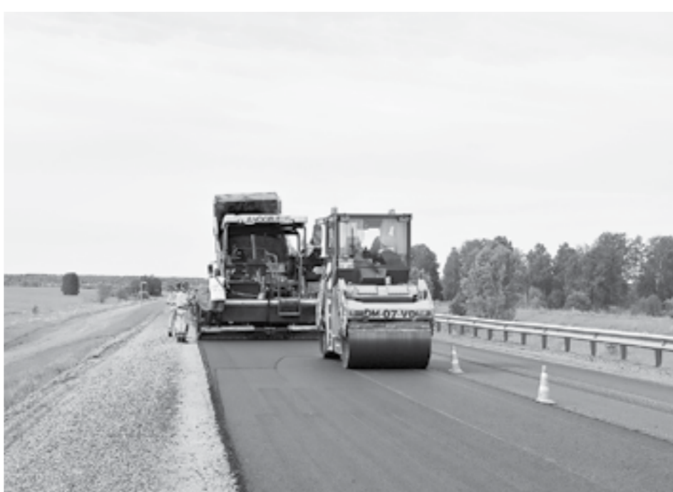
Укладна выравнивающего слоя.
