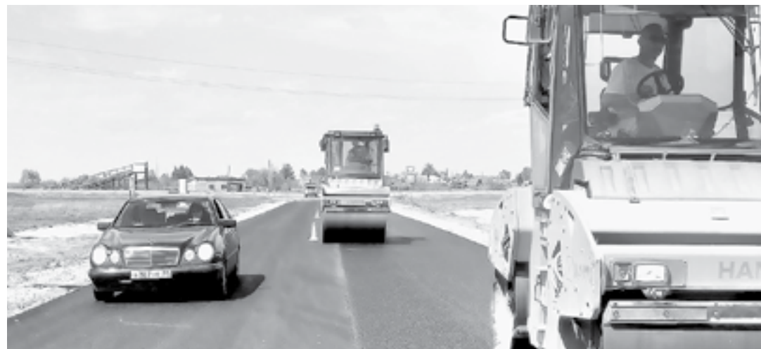
Проезжую часть на ул. Тракторной покрывают вторым слоем асфальта.
