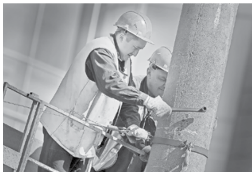
Рабочие монтируют растяжки электропроводов.
