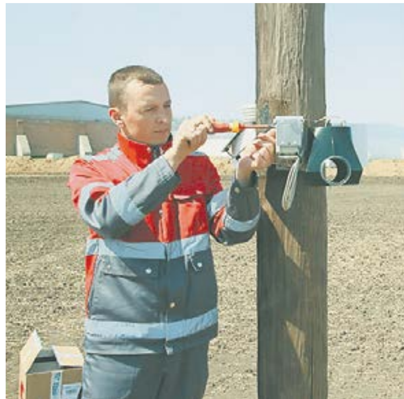
Заканчивается монтаж метеостанции.
