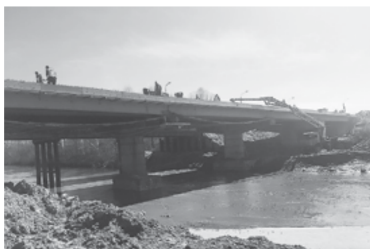
Длина ремонтируемого моста превышает 100 метров.
