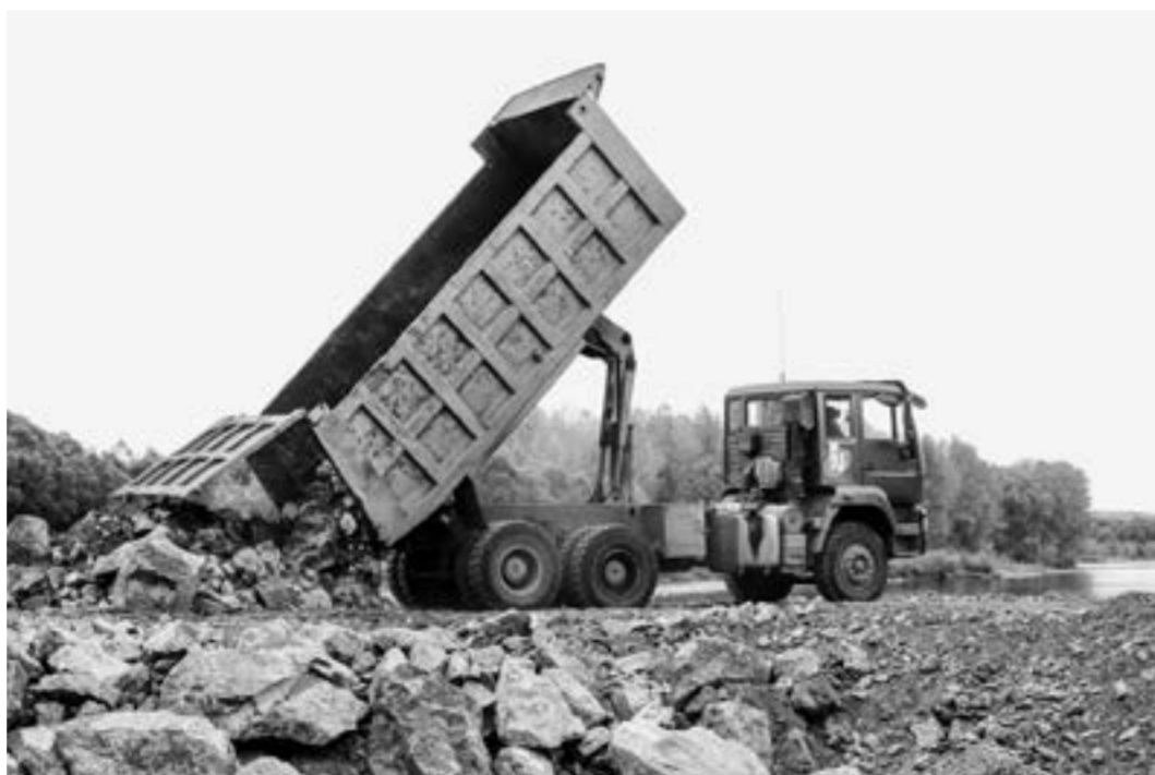
Работы по устройству защитной дамбы на русле реки Чарыш.
