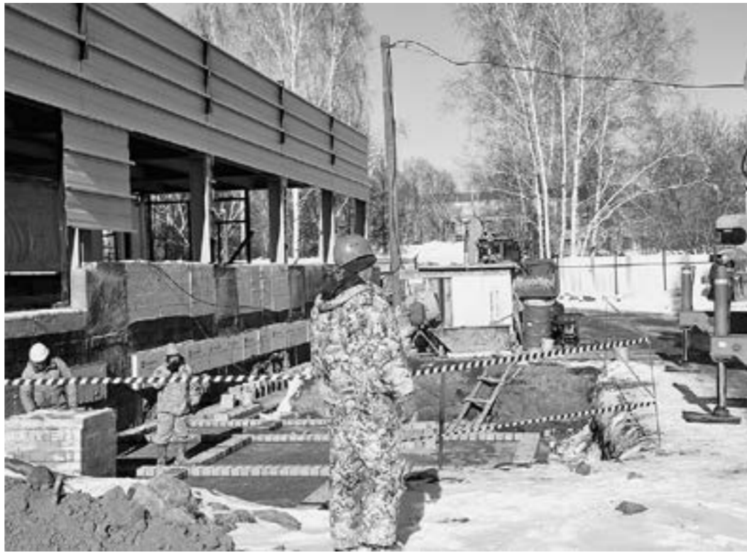
Строительство спорткомплекса в рамках нацпроекта чересчур затянулось.
