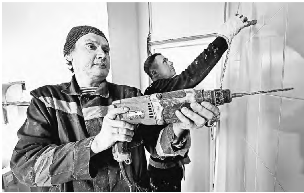
Евгений Супрунов и Михаил Пантелеев ведут монтажные работы.
