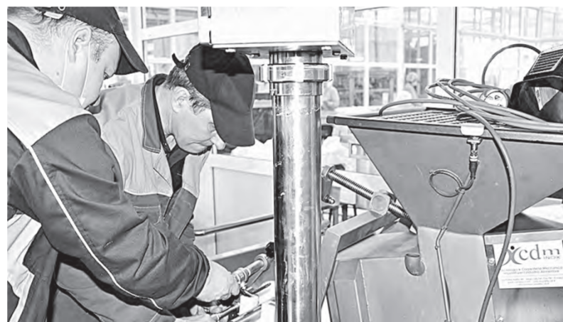
Наладка линии близка к завершению.
