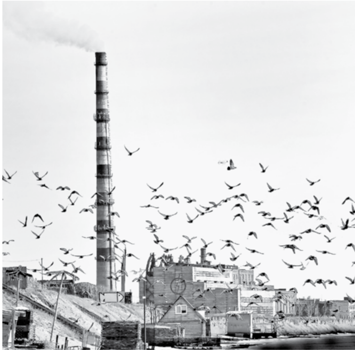
Единственный источник теплоснабжения города пережил много аварий.
