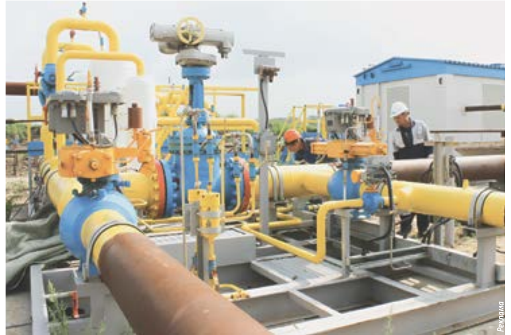
Газораспределительная станция села Ребриха.
