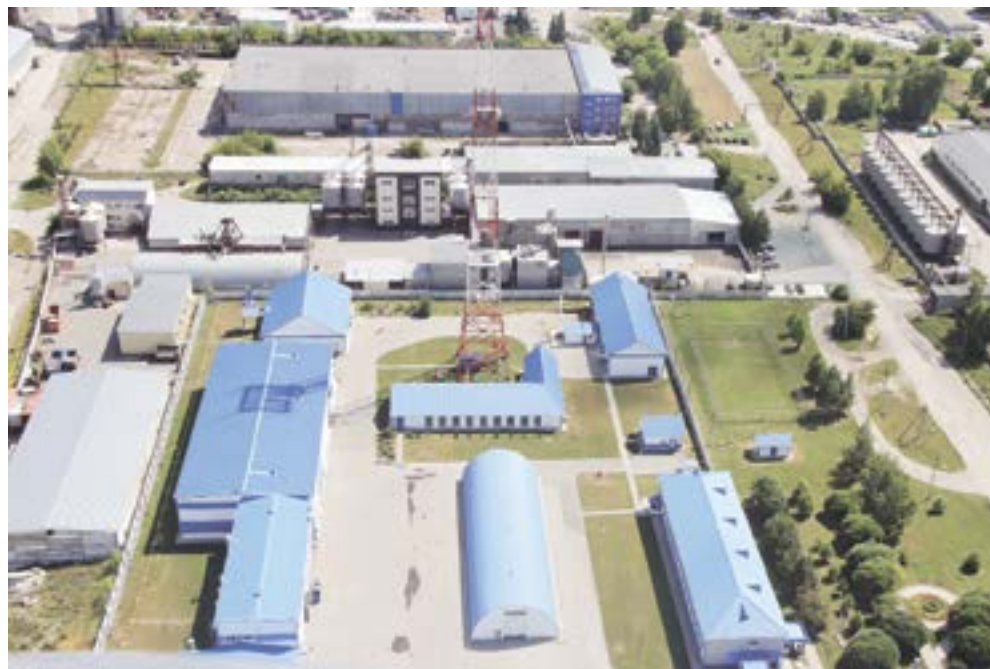
Алтайское ЛПУМГ ООО «Газпром трансгаз Томск» с высоты птичьего полета.
