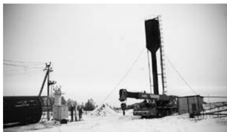
Ремонт водонапорной башни в селе Бавео.
