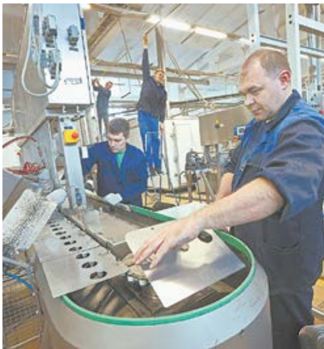
На монтаже новой линии «Алтайхолода».
