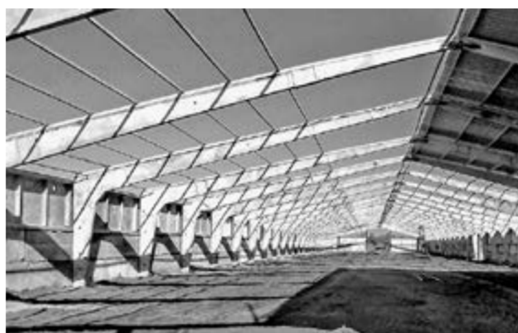
Строящийся склад под новый урожай.
