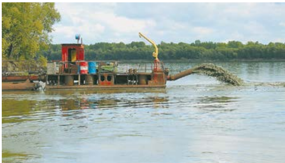
Ненужный грунт сгружают в отвалы, откуда его унесет течением.
