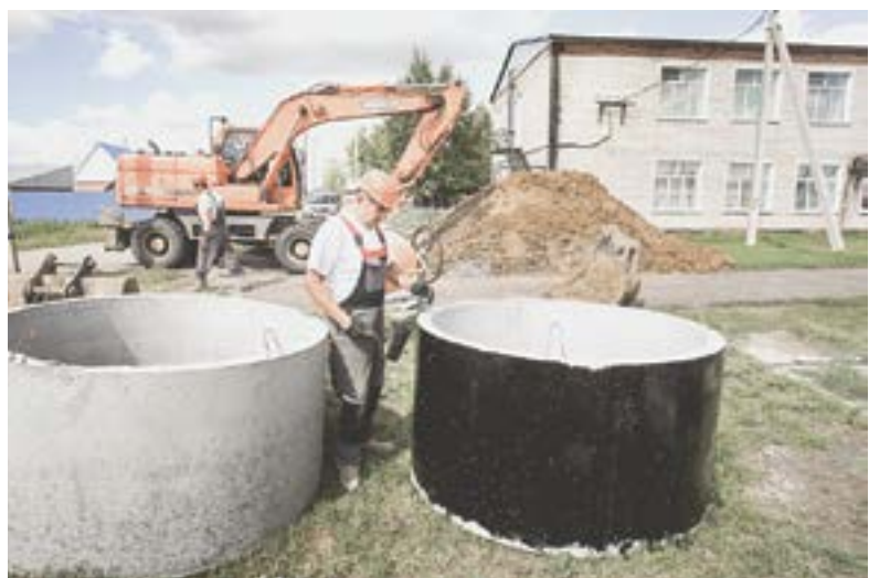
В Родино установят 600 водопроводных колодцев.
