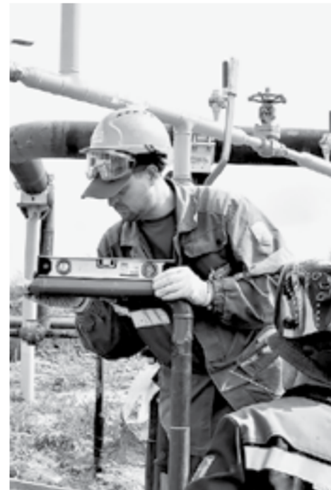
Монтажники тщательно вымеряют каждый стык перед тем, как приварить.
