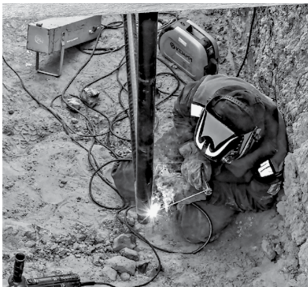
Сварщики работают и в траншеях.
