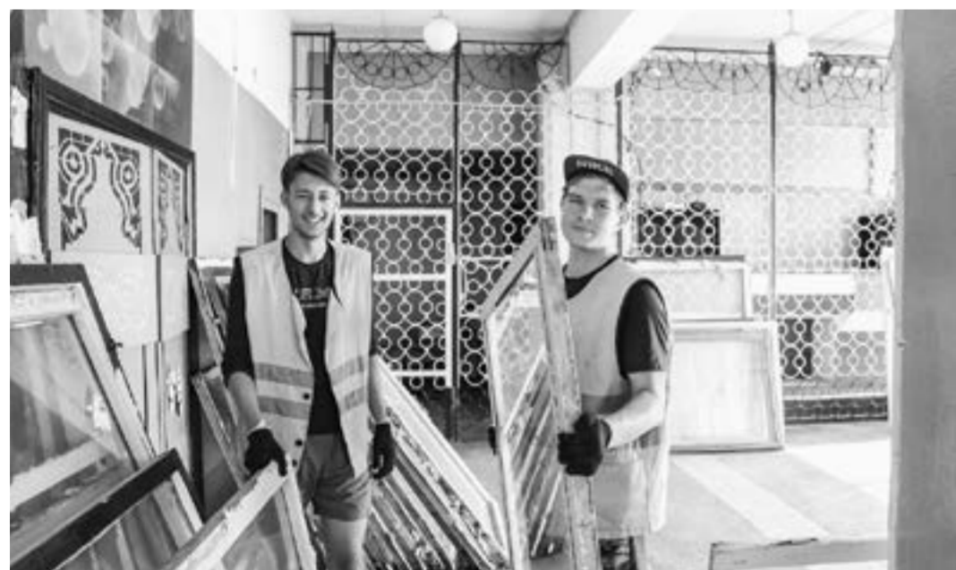
Школьники заняты ремонтом в Веселоярском Доме культуры.
