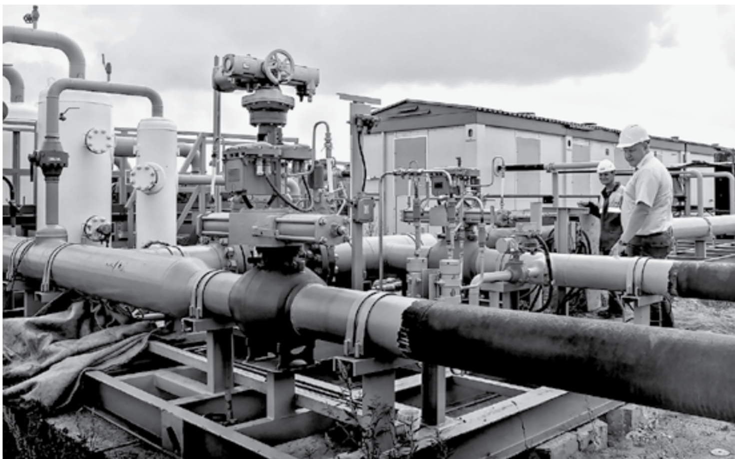
ГРС предназначена для подготовки газа к подачи потребителям.
