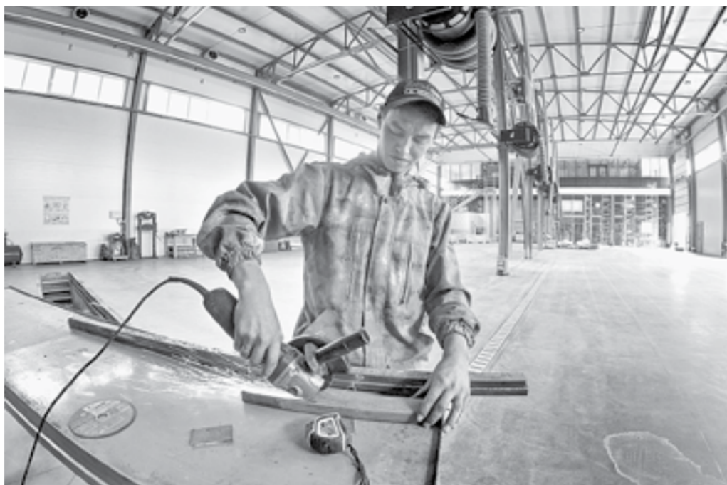
Завершается строительство теплого гаража.
