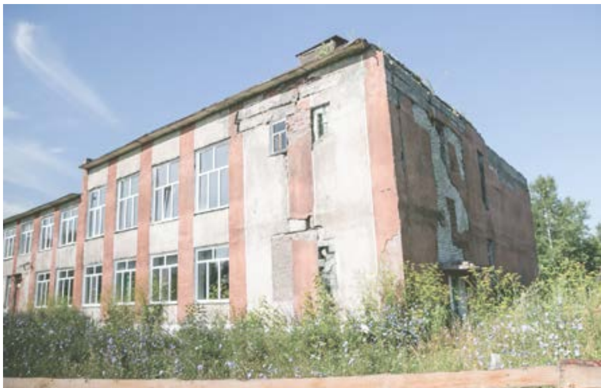
Осенью начнется реконструкция старого здания Беловской школы.
