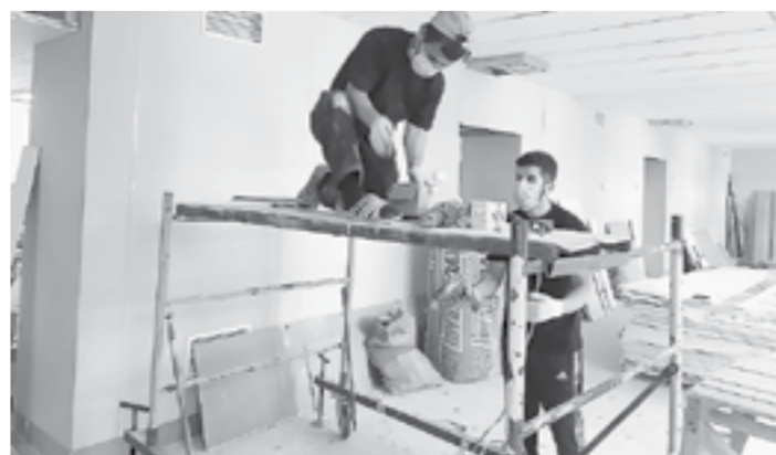
Строительная готовность объекта 90%.
