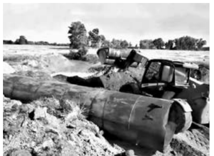
Ремонт плотины в селе Кочки.
