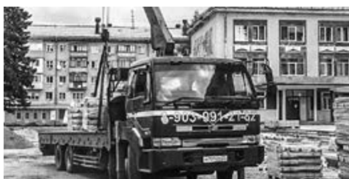
Разгрузка строительных материалов.
