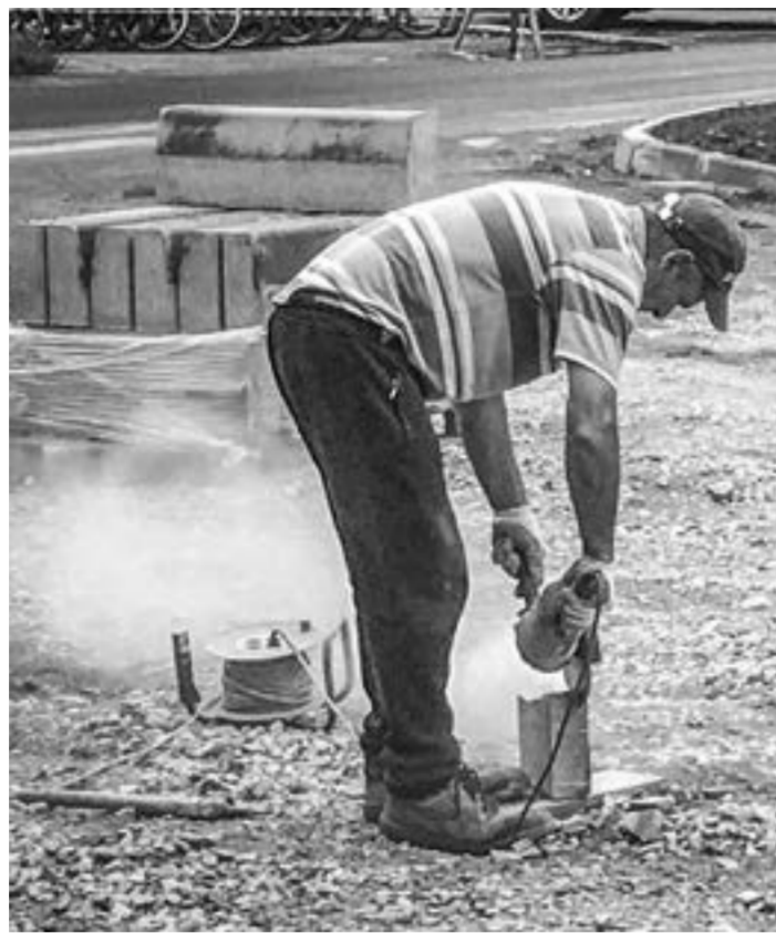
Подготовка к укладке плитки.
