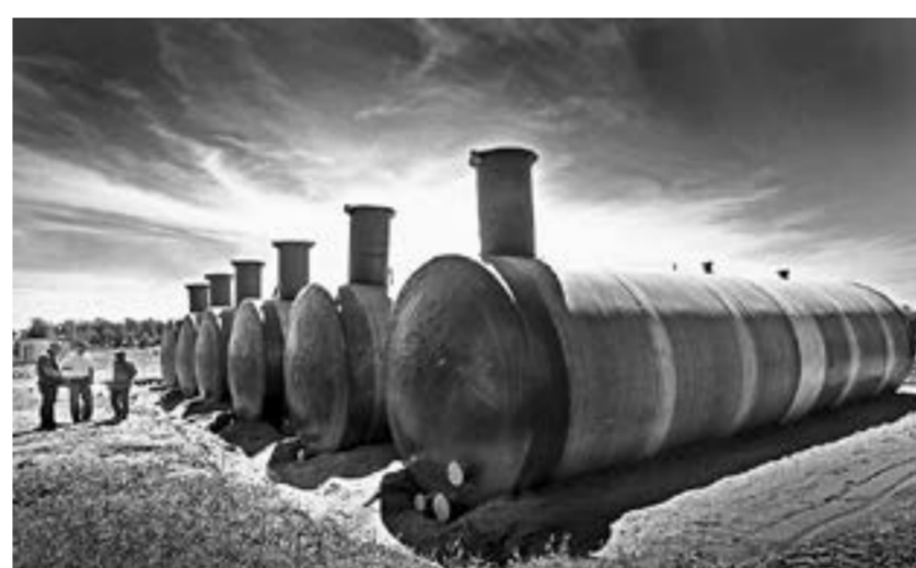
Эти емкости для чистой воды утепляют и засыпают землей.
