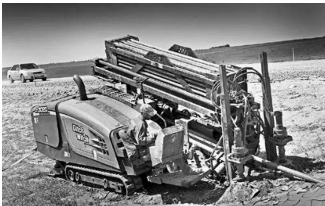
За день паная машина бурит под землей отверстие длиной 130–140 метров.
