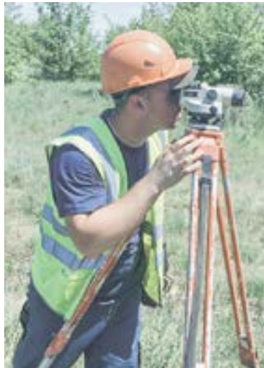
При помощи нивелира контролируется глубина закладки трубы.
