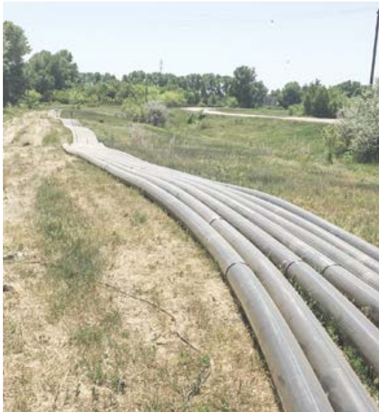
Протяженность нового водовода составит 10,5 км.
