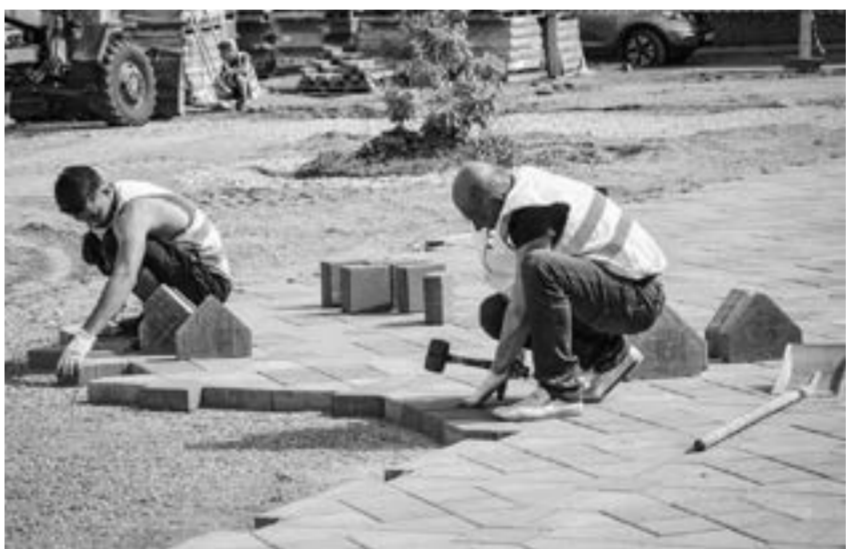
Строители ведут укладку плитки.
