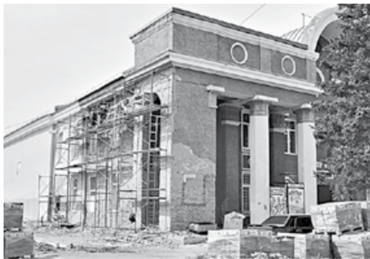
Фасад Театра кукол капитально ремонтируют.
