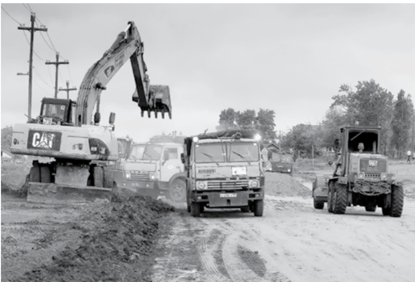
Работы идут полным ходом.
