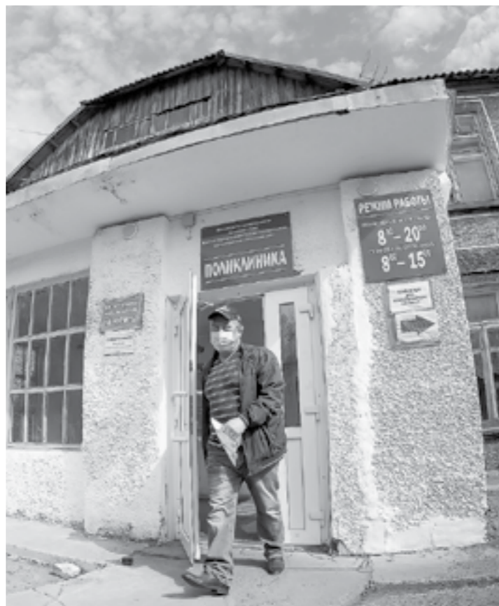
Ремонт не за горами.
