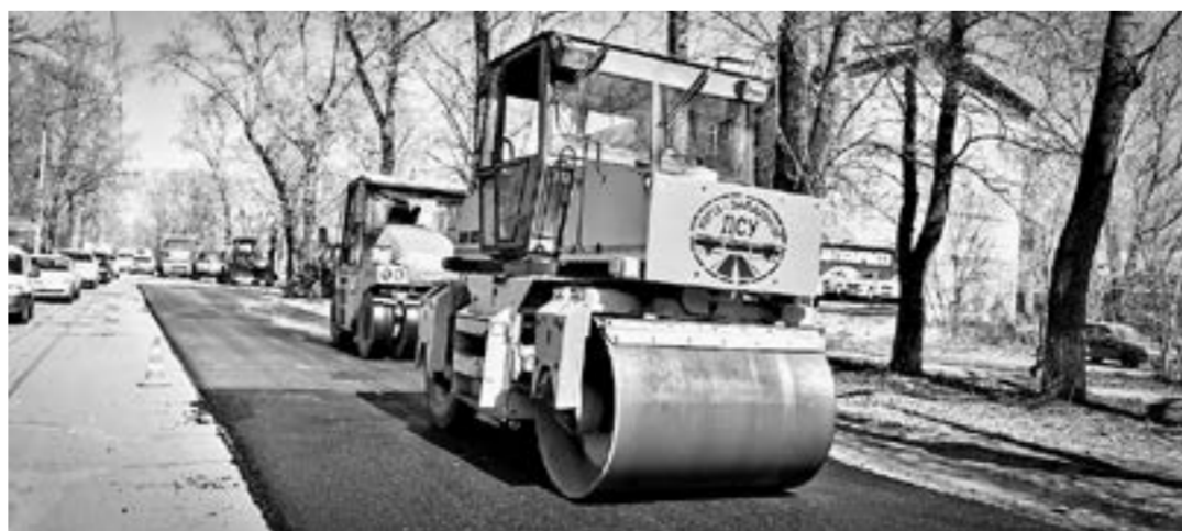
Юго-Западное ДСУ приступило к ремонту дорог в Рубцовском районе.
