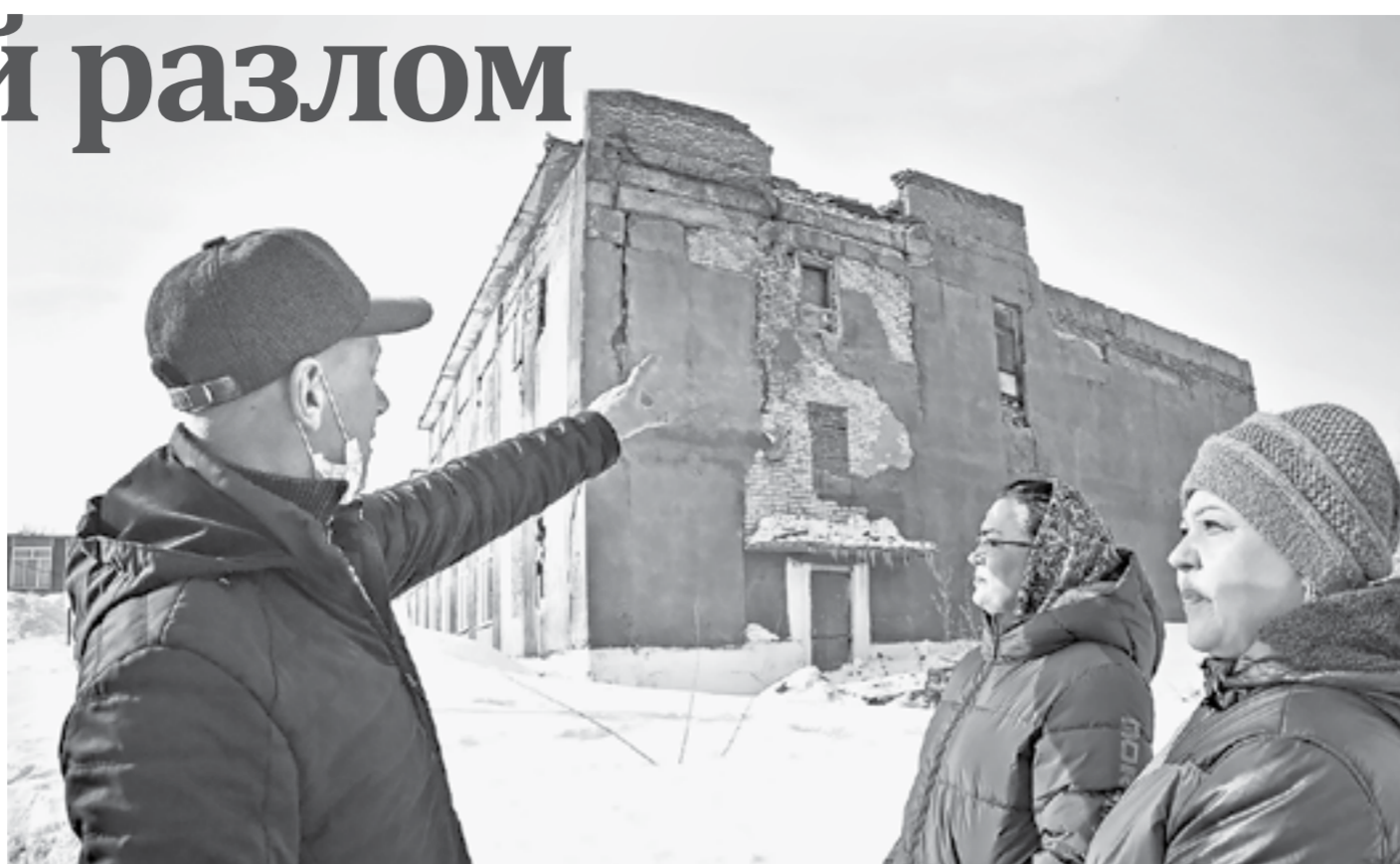
Завхоз Владимир Панин и родители школьников каждый день проводят осмотр здания.
