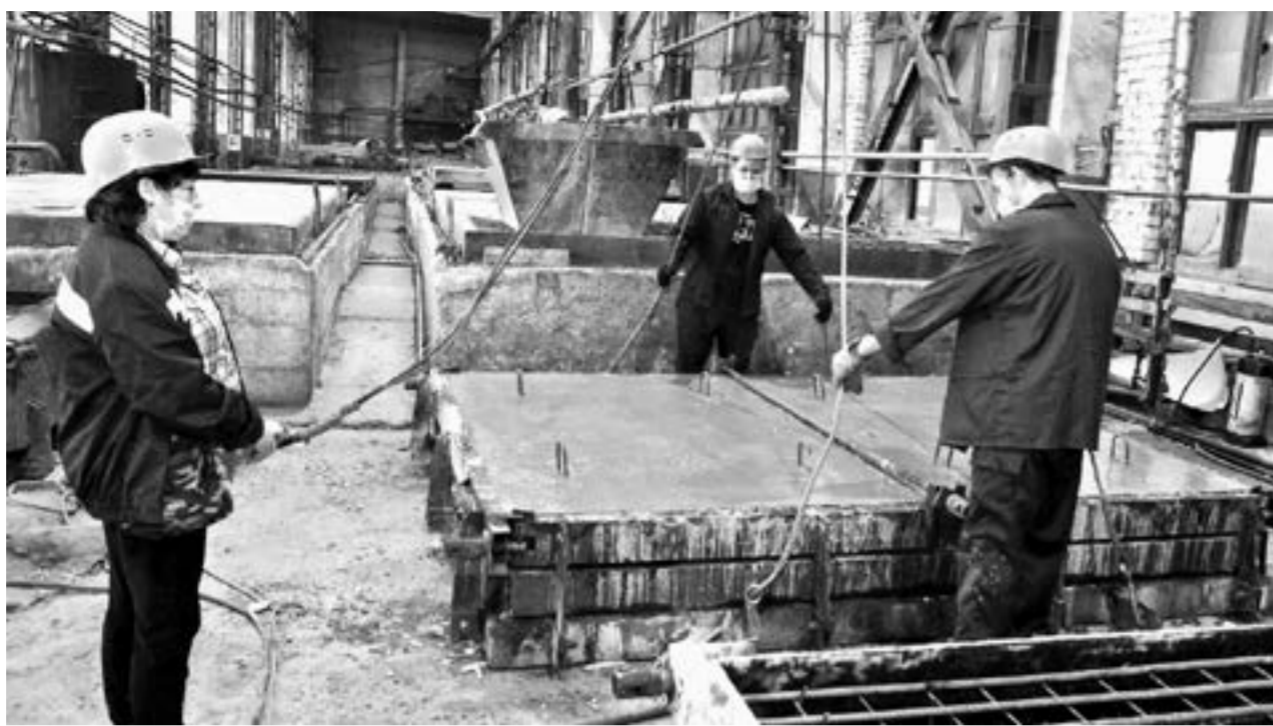
Идет формовка опоры трубы.
