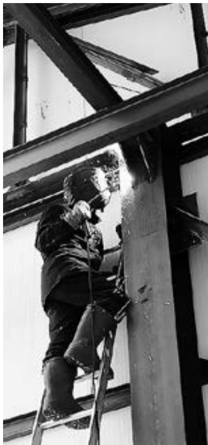
Строительство нового корпуса.
