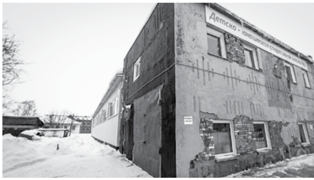
Одна часть отремонтирована, на очереди вторая!
