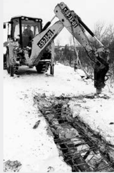
Гидромолотами разбирают верх моста.
