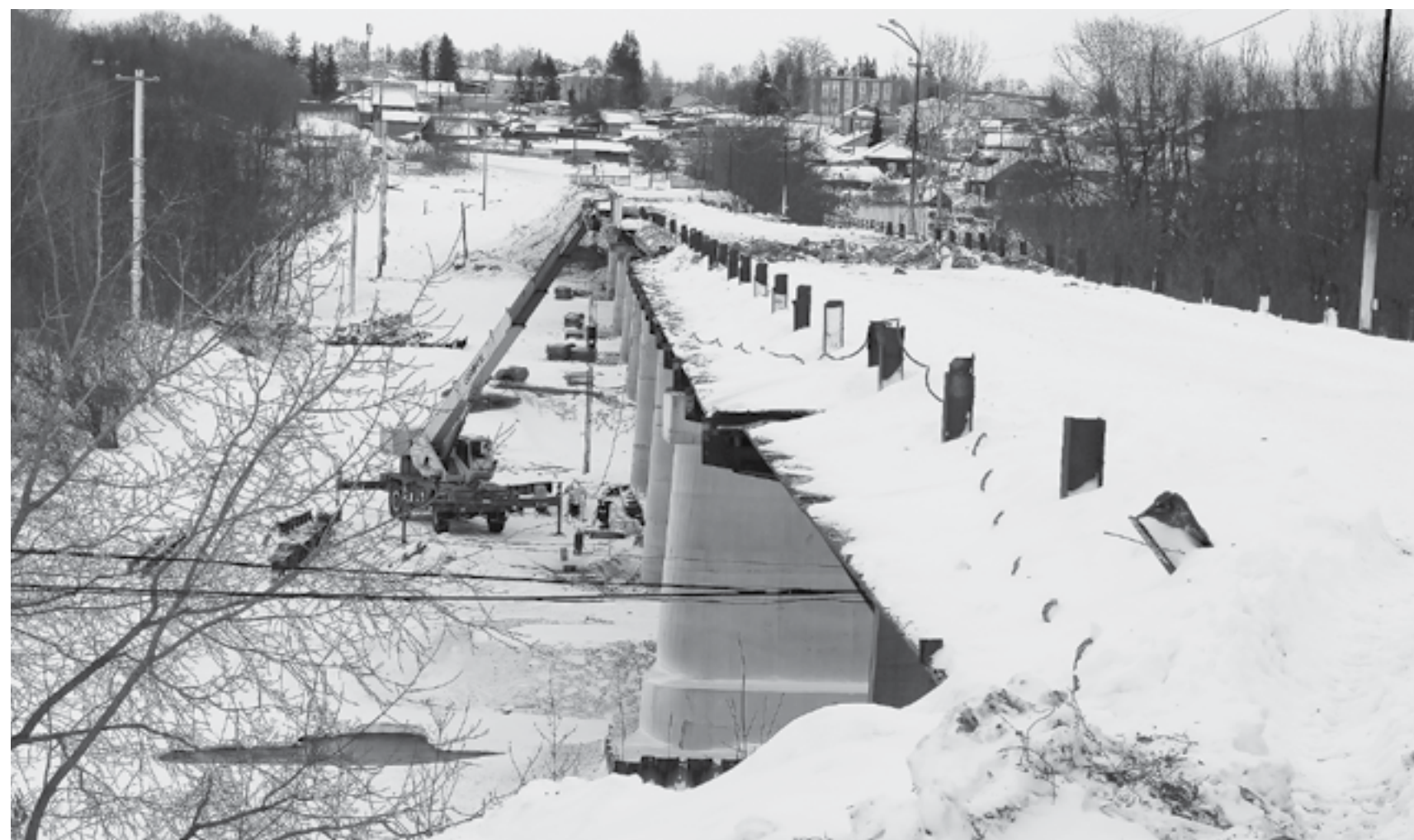
Ремонт моста через Чумыш только начался.
