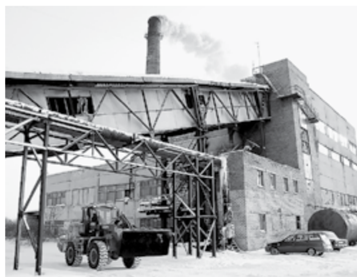
На самой крупной в Камне котельной № 29 теперь есть два резервных котла.
