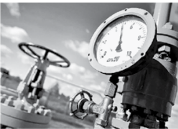
Краевые власти советуют жителям села Боровиха обращаться по вопросам монтажа газозового оборудования в «Газпром газораспределение Барнаул».
