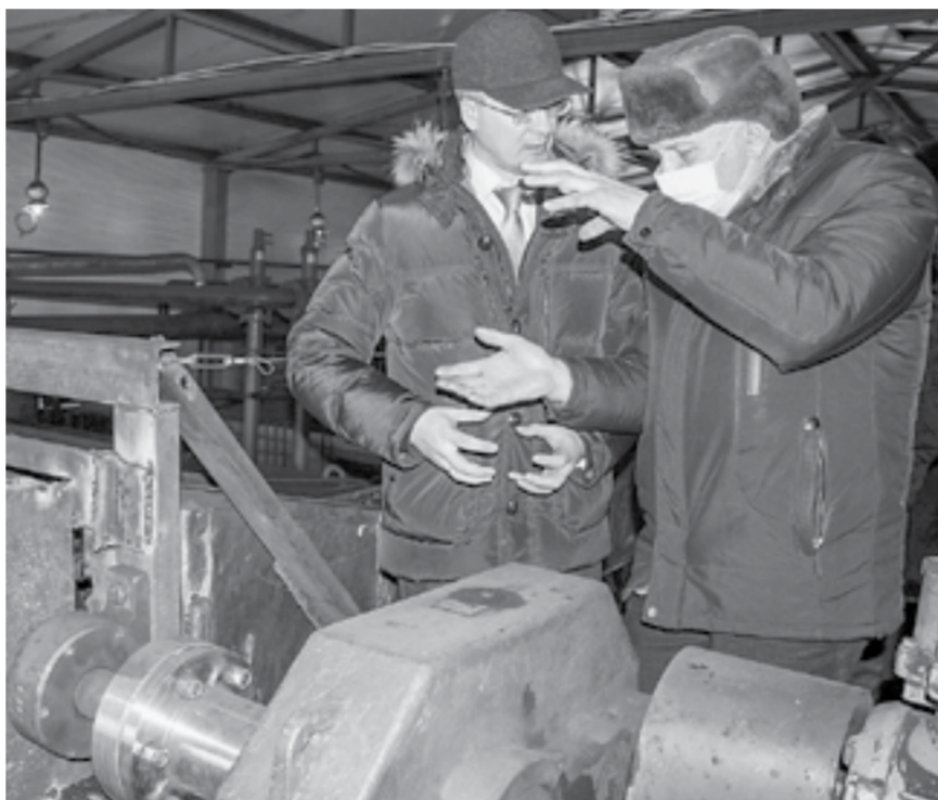
Валерий Басманов объясняет Ивану Гилёву, что произошло на котельной № 44.
