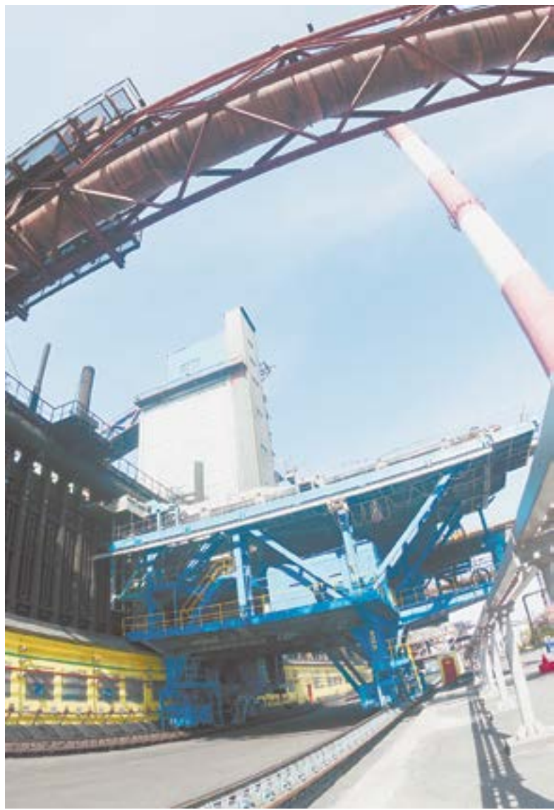
Комплекс трамбования угля пятой ноксовой батареи «Алтайнокса» был сдан в прошлом году.
