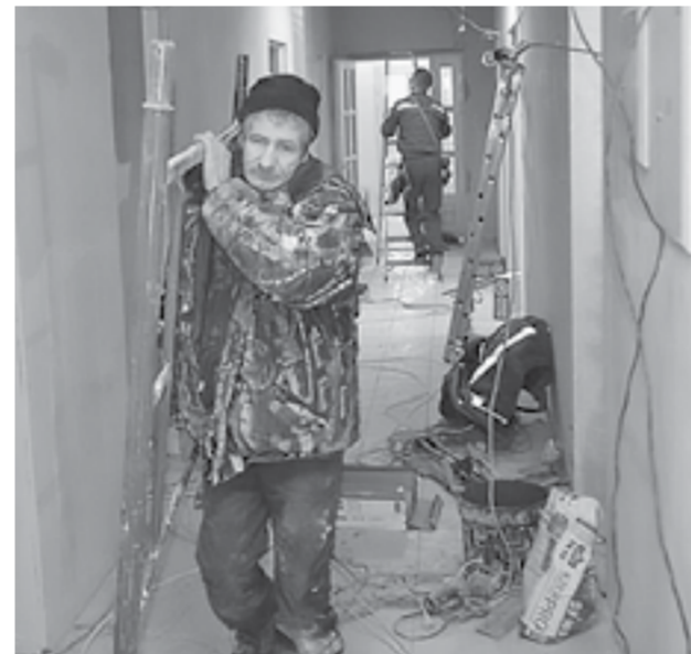
Заканчивается внутренняя отделка здания.
