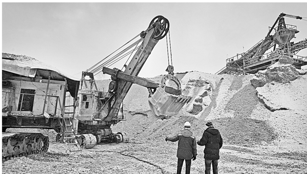
Электрический экскаватор грузит гравий на переработку.
