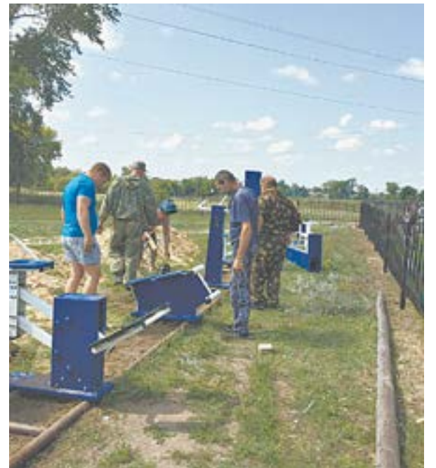
Идет монтаж новых тренажеров.
