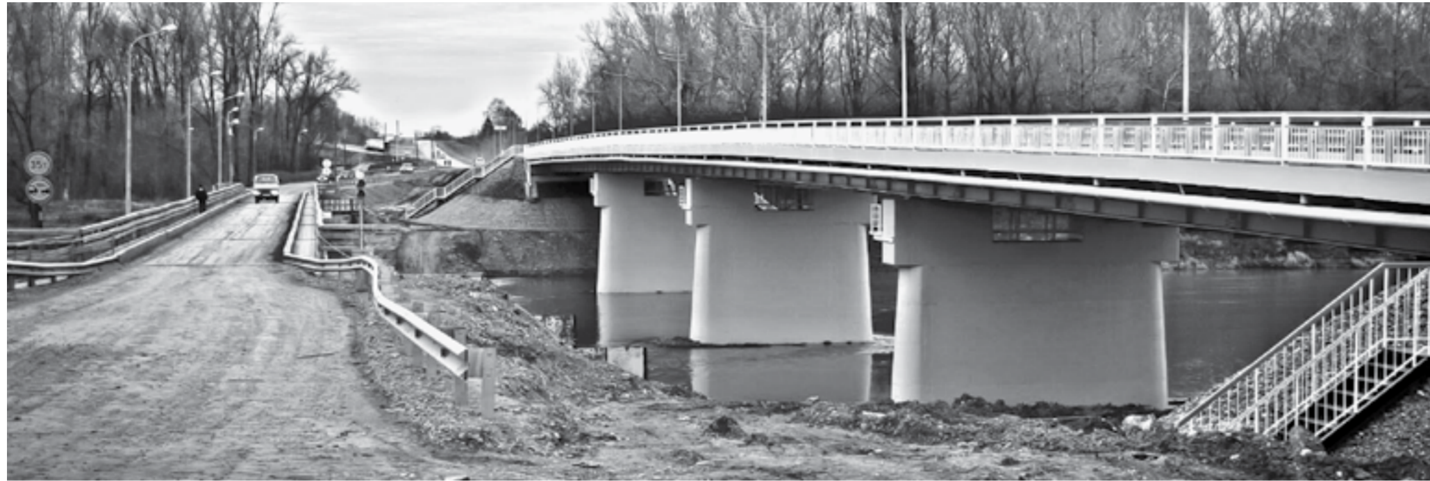
Новый мост через Чумыш возведен в рекордно короткие сроки.
