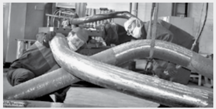
Подготовка труб для очередного котла.
