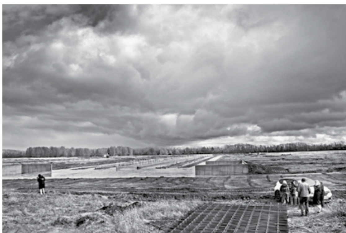
На строительной площадке «ЭкоНива Алтай».
