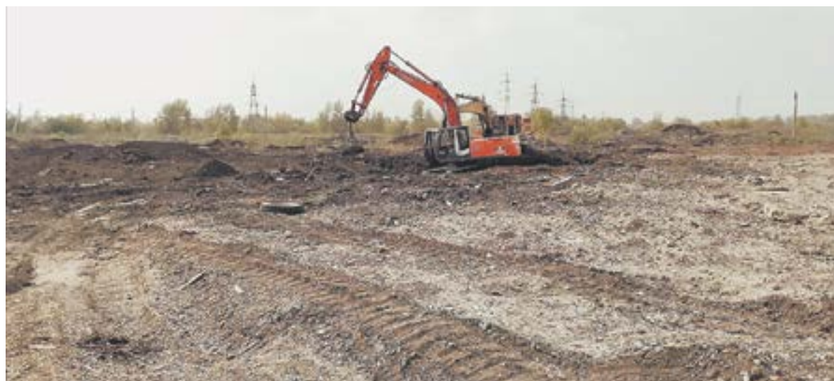
Началась рекультивация земельного участка.
